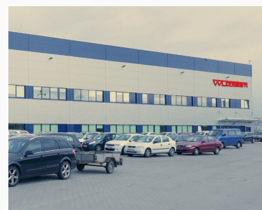
Budynek WUZETEM z zewnątrz
