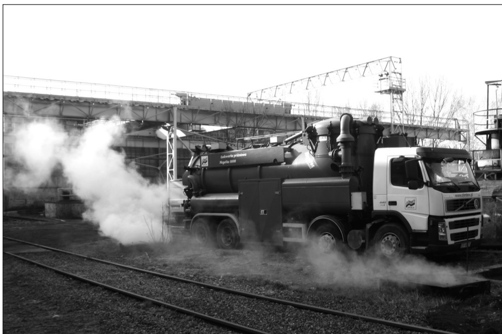
Samochód próżniowy podczas usuwania zanieczyszczeń ze zbiorników na terenie Walcowni Blach Grubych.
